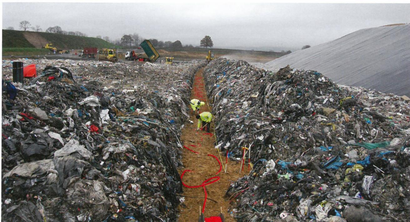
Installation de capteurs géophysiques au sein d'un casier de déchets en exploitation.
